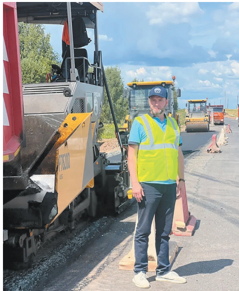
ЭТО КРУПНЕЙШИЙ ДОРОЖНЫЙ ОБЪЕКТ КАПИТАЛЬНОГО РЕМОНТА 2025 ГОДА В КИРОВСКОЙ ОБЛАСТИ.
